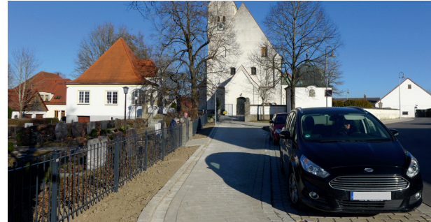
Mehr Platz für Fußgänger, Haltemöglichkeiten für Friedhofsbesucher, Anfahrtsfläche für Bestattungsunternehmen: Mit dem Zurücksetzen des Friedhofzauns wurde eine flexiblere Nutzung möglich.
