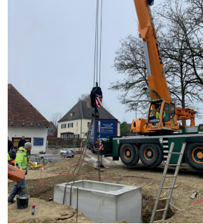
Betonfundament für den Maibaum
