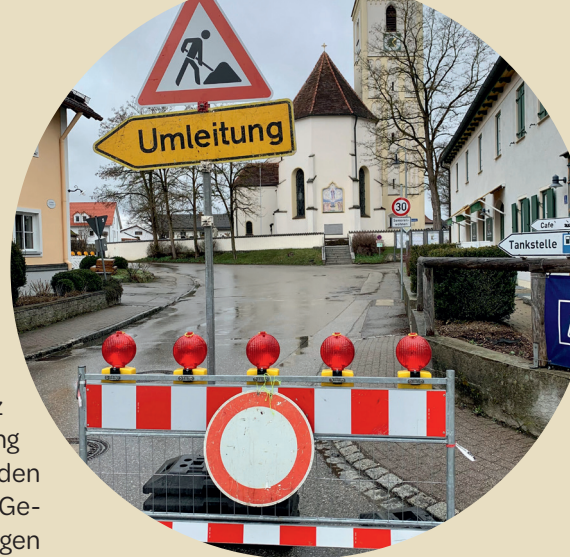
Baubeginn im März 2021
