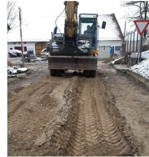
Immer wieder Erdarbeiten!
