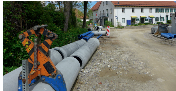
Neue Rohre für Wasserleitung und Regenwasserkanal
